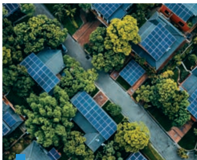
Pannelli fotovoltaici installati su abitazioni.
